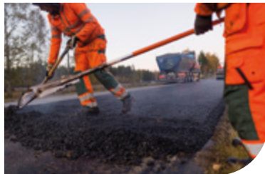
Baustoffe und Asphalt
